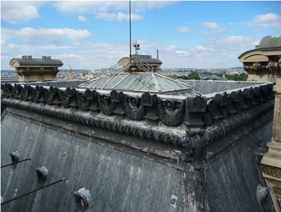
Photographie montrant l'ampleur en plomb moulé du couronnement du pavillon de Marsan.
