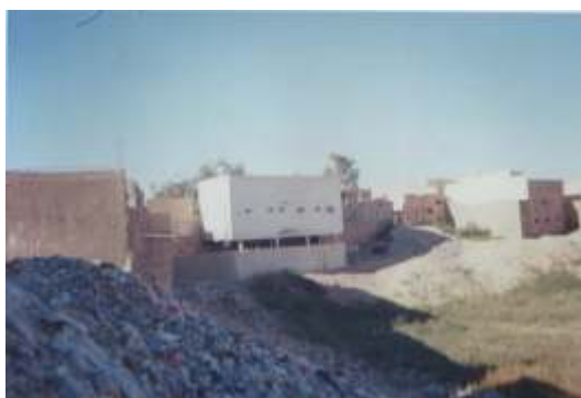
Photo 5 – Inondation et destruction du bâti dans les bas quartiers de la ville d'El Oued
