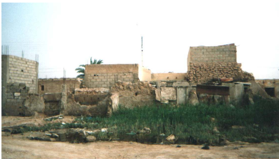
Photo 4 – Inondation et destruction du bâti dans les bas quartiers de la ville d'El Oued
