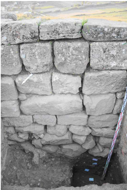
Fig. 8 – Le mur F.
