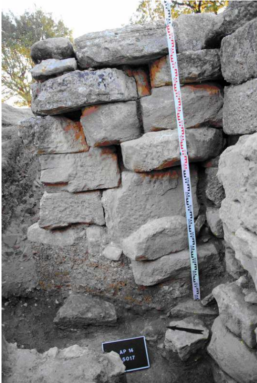
Fig. 9 – La paroi ouest de la cage d'escalier.
