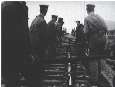
L'ÉLECTRIFICATION IMPOSE LE CHANGEMENT DES RAILS
