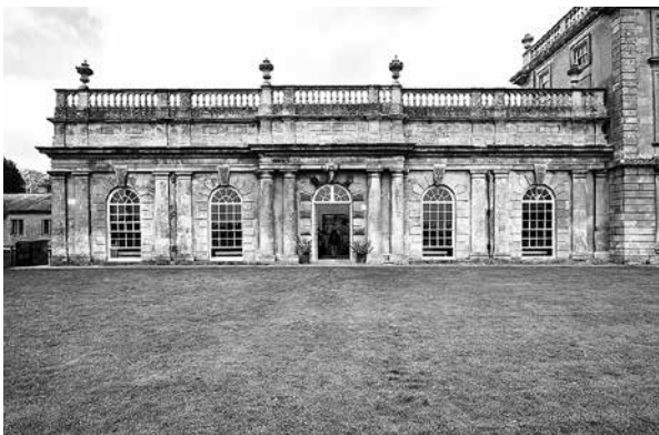
11. Serre à Dyrham Park, construite à partir de 1701.
