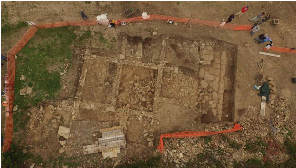
Fig. 5 – Veduta aerea dell'area indagata : in evidenza il tratto di mura urbane e gli ambienti adiacenti.
