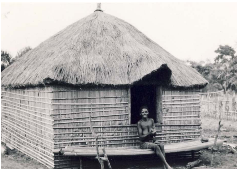
Cette maison mbunda (Ifwazondo, T.d'Idiofa), aux parois renforcées par un treillis de lattes, a un toit de paille qui ressemble à la coupole de la maison pende. Un arceau du toit se prolonge en auvent au-dessus de la porte-fenêtre. Une photo d'une maison très semblable, du milieu de la première décennie du XIX e siècle, figure dans un ouvrage de Torday et Joyce 3 de 1922 (pl. XV).
