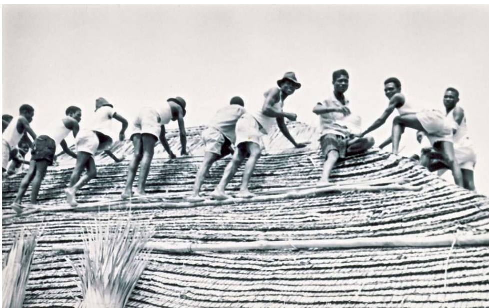
La construction d'une maison est une tâche collective qui rassemble plusieurs hommes du clan ou du village. Ils achèvent ici de couvrir le toit de feuilles ndala (folioles d'un palmier de la forêt). Village Pumbi, en bordure du Kasai, nord du Territoire d'Idiofa.
