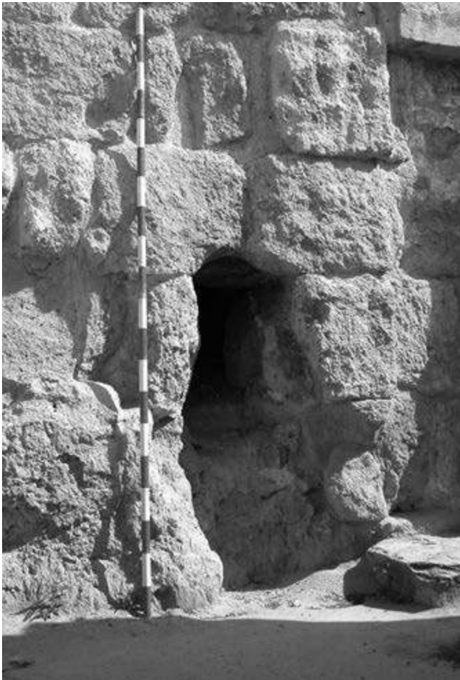
Fig. 2a. Entrée de l'adduction d'eau dans l'« Édifice supérieur oriental » (n° 7) (Cliché S. Escobar Montero)
