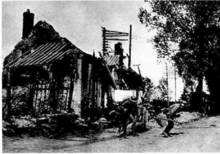
Durch das gestürzte Pont Arcy sich vorarbeitende Infanterie (Abb. 22)
