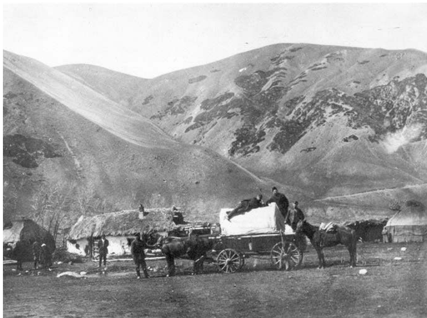
Photo 6. Village de Ionovka, (région de Pišpek, Kirghizie, 1925). Maisons détruites des habitants slaves expulsés pendant la réforme de la terre et de l'eau de 1921-1922, occupées par les Kirghiz qui s'en servaient comme étables. La photo a été prise au moment du passage de la commission Serafimov dans le village (au premier plan, la voiture de la commission). RGASPI 17/85/105/87.
