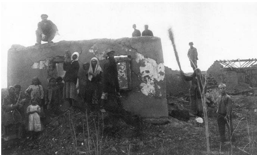
Photo 10. Les retours. « Village de Jur'evka dans l'okrug de Pišpek, dans la région autonome de Kirghizie (K.A.O.). Maison détruite de la veuve Kravkov, expulsée pendant la réforme terrienne. Pour son retour dans la vieille maison, les paysans [du village] l'aidèrent et reconstruisirent le bâtiment » (légende originale du fonds d'archives).
