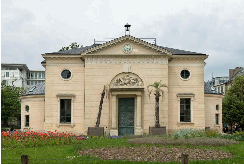
Amphithéâtre, élévation antérieure, vue générale.
