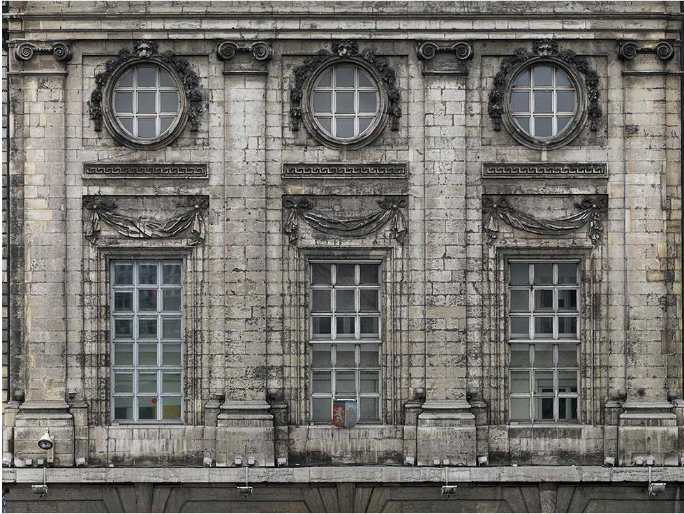
DÉTAIL DE LA FAÇADE DE L'HÔTEL-DIEU DE LYON (RHÔNE).
