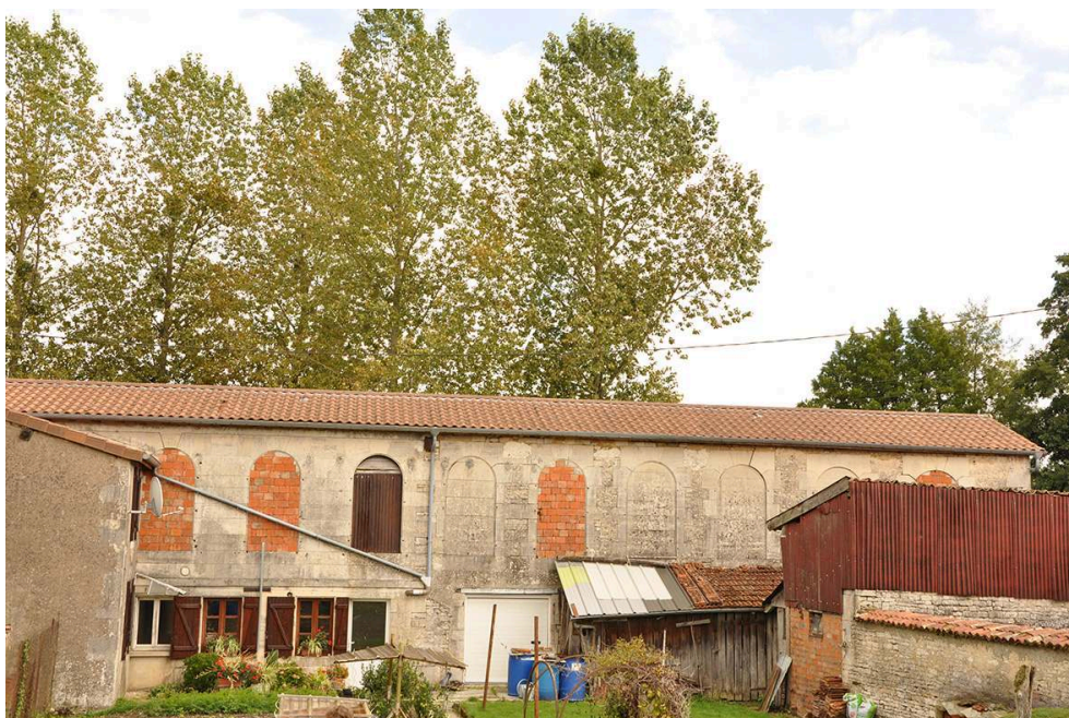
Façade du théâtre de l'établissement orthopédique de Morley, côté jardin du levant, 1826. État actuel, rue du Docteur Humbert, 55290 Morley.
