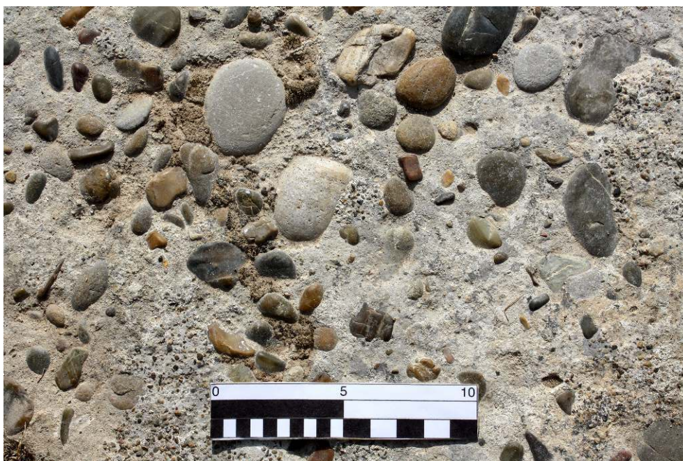
Fig. 21 – Pièce I. Sol en béton de galets.
