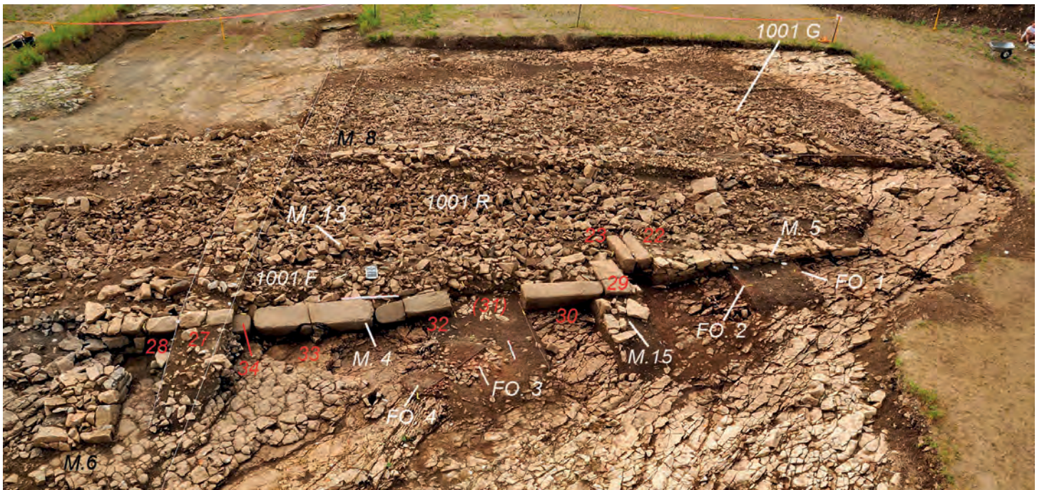
■ 30 Vue d'ensemble de la façade nord-ouest du monument B avec notamment les parements M. 4 et M. 5 (état fin 2011). Les chiffres en rouge indiquent les numéros des stèles en grès.
