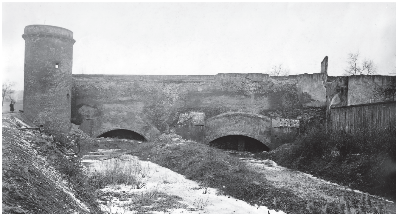
Fig. 11. Vue du pont des Grilles de la Basse-Seille depuis le nord-est en 1911 (© Musée de La Cour d'Or – Metz Métropole).
