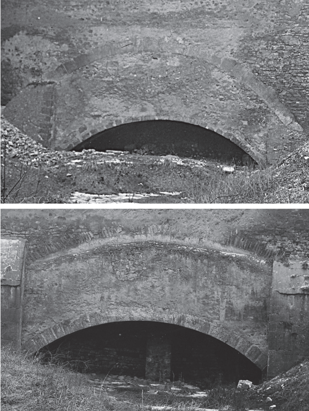
Fig. 12. Vue des arches inférieures orientale (en haut) et occidentale (en bas) depuis le nord-est en 1911. On distingue un appareillage différent. Détails (© Musée de La Cour d'Or – Metz Métropole).
