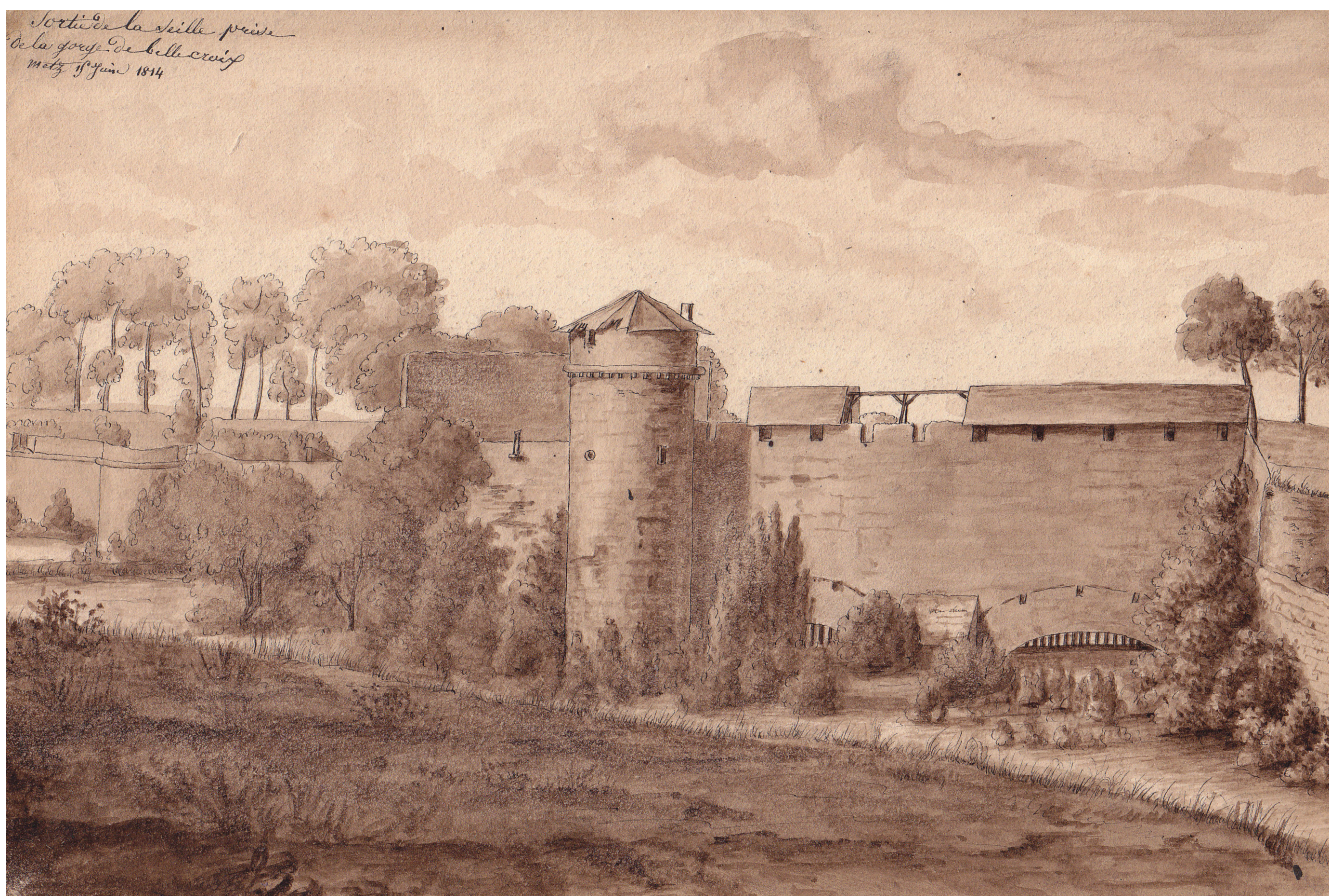
Fig. 10. Dessin anonyme du pont des Grilles de la Basse-Seille en 1814 vu depuis le nord-est. L'ouvrage est encore pourvu de sa toiture et de son crénelage (coll. particulière).
