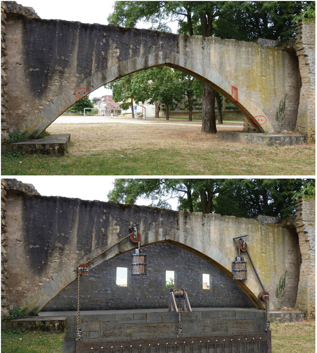
Fig. 15. Localisation des vestiges du système de contrepoids (en haut, en rouge) et essai de restitution du mécanisme des grilles du pont (en bas) (infographie : N. Gasseau).
