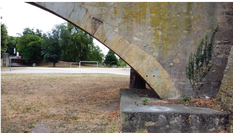
◀ Fig. 6. Départ occidental de l'arche brisée. Il présente une orientation sensiblement différente de celle du reste de l'ouvrage. On distingue également les deux orifices et la zone creusée dans la pierre laissés par le système de contrepoids (cliché : J. Trapp).
