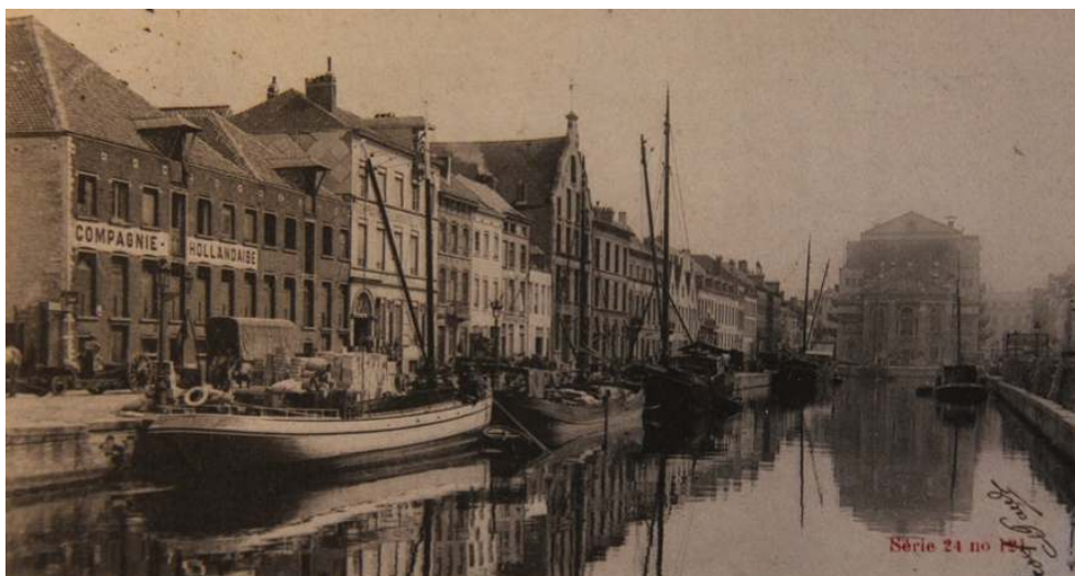
Figure 2. Vue des quais de Bruxelles au XIX e siècle avec, à gauche, l'entrepôt de foin (1841) de l'Ancienne Compagnie Hollandaise. Deux poulies protégées par des chiens-assis et des portes étagées permettaient de hisser le fourrage dans le bâtiment. Quai au Foin 59-60.
