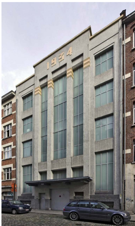
Figuur 9. Voor de gevel van het textielpakhuis Etablissements I. & M. Blum (1934) werd gebruik gemaakt van cimorné 14 , een typische interbellum cementversieringstechniek.
