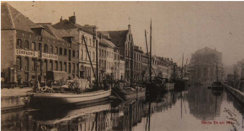
Figuur 2. Negentiende-eeuws zicht op de haven van Brussel. Aan de linkerkant het Hooipakhuis (1841) van de Oude Hollandse Compagnie met twee katrollen met beschermkap en op elke verdieping deuren om het hooi in het gebouw te tillen. Hooikaai 59-60.
