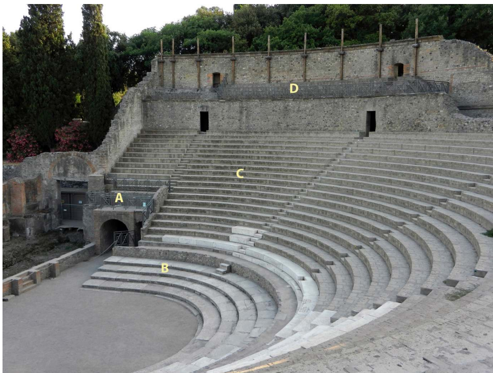
Fig. 3 – Vue du grand théâtre de Pompéi en 2014 (après la restauration des gradins de 2010). A : tribune latérale ; B : proédrie ; C : ima cavea ; D : summa cavea .
