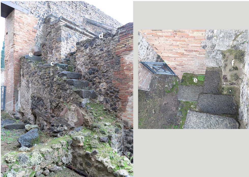
Fig. 28 – Vue de l'accès à la tribune latérale occidentale du theatrum tectum depuis la scène.
