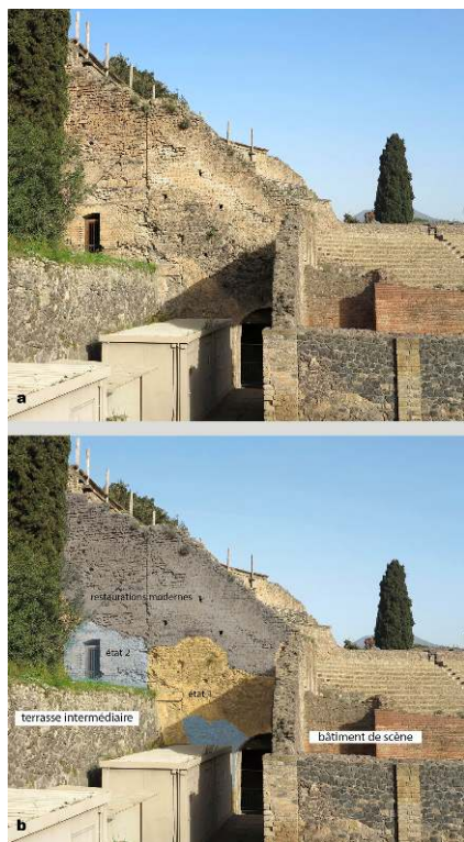
Fig. 6 – Partie occidentale de la face sud de l' aditus occidental du grand théâtre de Pompéi. Vue générale et repérage des états successifs.
