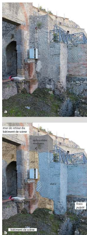
Fig. 8 – Extrémité orientale de la face sud de l' aditus occidental du grand théâtre de Pompéi. Vue d'ensemble et repérages des états successifs.
