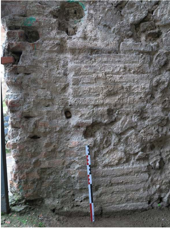
Fig. 17 – Traces de l'accroche du placage en marbre au débouché du vomitoire de l' ima cavea (vue du nord).
