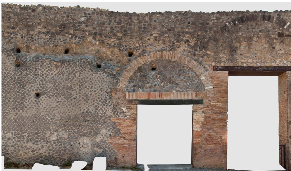
Fig. 21 – Entrée de l' aditus occidental (à gauche) et entrée latérale de la scène (à droite) du theatrum tectum de Pompéi.
