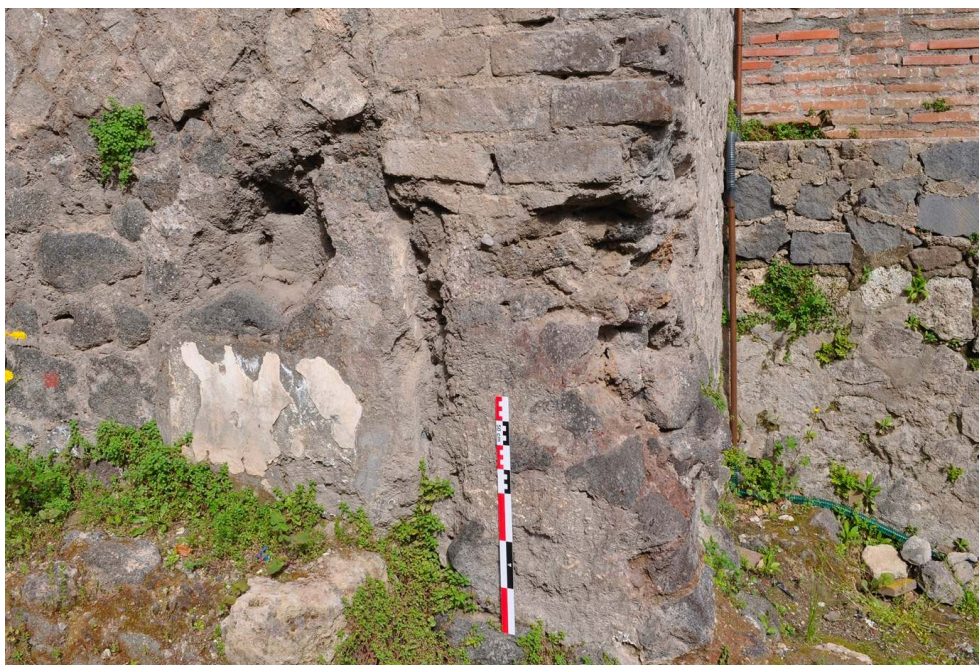
Fig. 9 – Conservation de l'enduit sur l'angle inférieur du mur en maçonnerie de lave correspondant à l'état 1 de l' aditus occidental de Pompéi (vue du sud).
