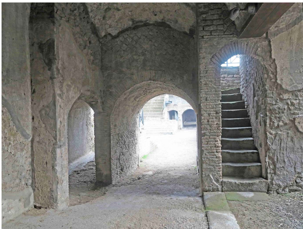
Fig. 12 – Vue depuis l'ouest du triple accès à l'intérieur du théâtre aménagé dans l'état 2 de l' aditus occidental.
