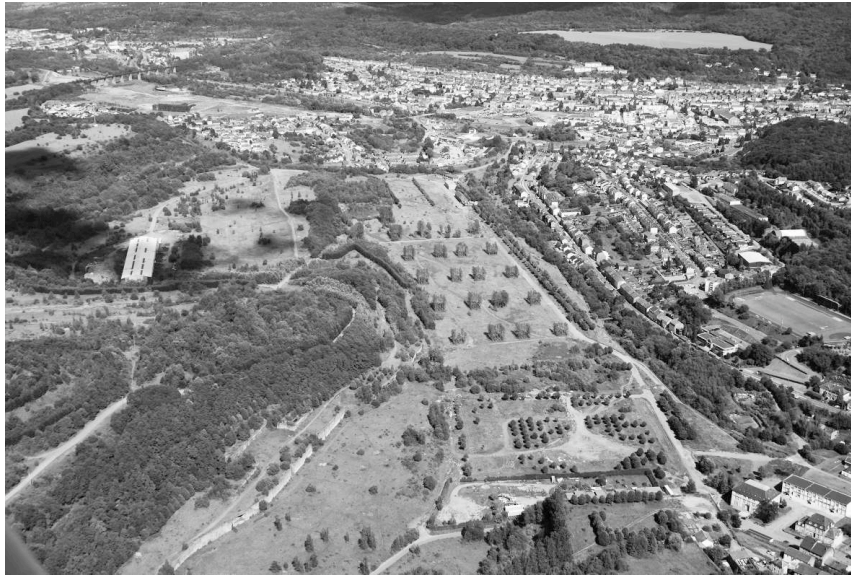
Photo 1 – L'ancien site sidérurgique de Micheville à Villerupt/Audun-le-Tiche Source : A. Humbert & C. Renard-Grandmontagne, 2009
