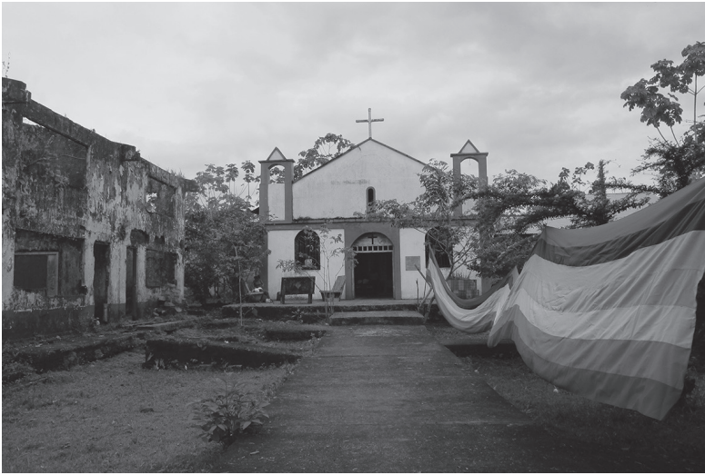
Figure 1 : L'église du vieux Bellavista, partiellement consolidée
