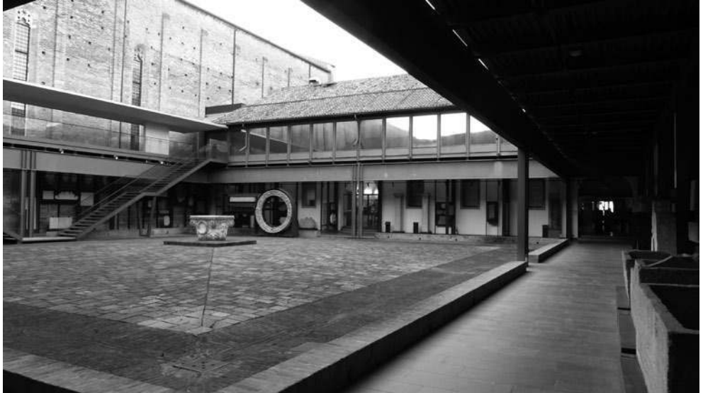
Padoue, degli Eremitani, aujourd'hui Museo Civico di Padova. Vue du grand cloître reconstruit (architectes : Franco Albini et Franca Helg). Photo N. Detry, 2013.
