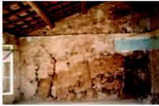
Fig. 2b : cliché et relevé des banchées sur le mur porteur et portant trace de banchées
