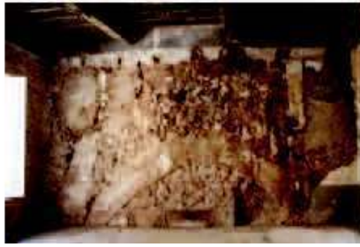
Fig. 2c : cliché et relevé d'un arc brisé d'un mur porteur construit partiellement en bauge
