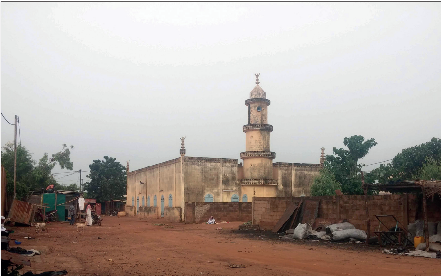
Photo 3 - La mosquée du marché de Dassasgho (Cliché : S. Sidbega, 2017)
