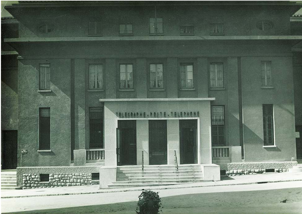
Anonyme, façade principale de l'hôtel des Postes de Toulon (Var), après reconstruction, 1953, photographie anonyme (AN, 19790443/38).
