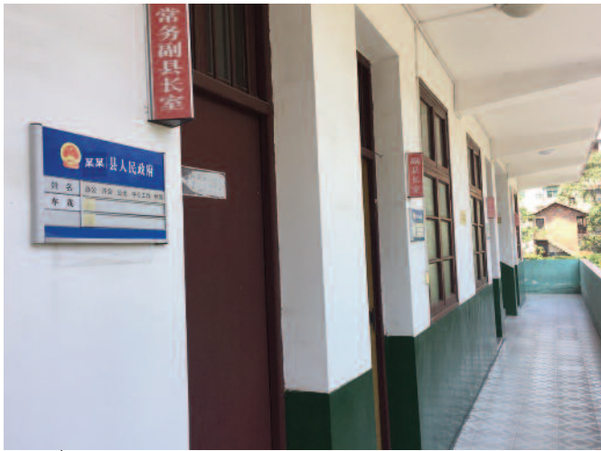
Photo 1 – Cette photo a été prise par l’auteure lors de son enquête de terrain au siège du gouvernement du district rural L, dans la province du Hunan, le 24 mai 2017. Cet immeuble fait partie de l’enceinte des bureaux du gouvernement du district rural situé à l’épicentre de la rue la plus importante et la plus fréquentée de la préfecture du district L, surveillé 24 heures sur 24. Cet édifice est composé de trois étages de bureaux équipés de meubles en bois délicat et agrémentés de murs fraîchement peints. Comme le montre la photo, chaque bureau est attribué à l’un des dirigeants du gouvernement ou de ses départements subalternes. Chaque pièce possède un balcon faisant face au jardin. © Yunyun Zhou
