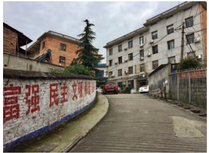
Photo 2 – Cette photographie d’un accès à un bâtiment vétuste et mal entretenu a été prise par l’auteure le 25 mai 2017. C’est là que se trouvent les bureaux de la Fédération des Femmes du district et de plusieurs autres organisations. Le bâtiment est difficilement reconnaissable et accessible pour une personne extérieure, caché par plusieurs blocs résidentiels et disposant d’une porte étroite. Les résidents et commerçants vivant et travaillant à proximité que j’ai interrogés m’ont confié qu’ils n’étaient pas au courant de l’emplacement exact de la Fédération des Femmes. À l’intérieur du bâtiment, les deux premiers étages sont des bureaux assignés à la FF au sein desquels 2 ou 3 cadres partagent le même bureau. © Yunyun Zhou
