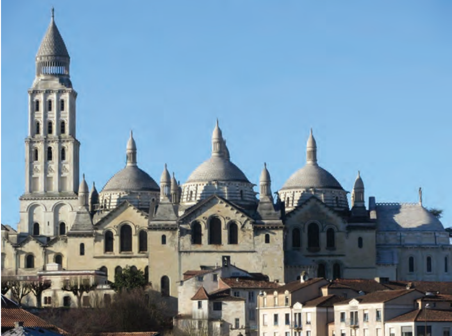
Fig. 1: Saint Front de Périgueux (photo de l'auteur)
