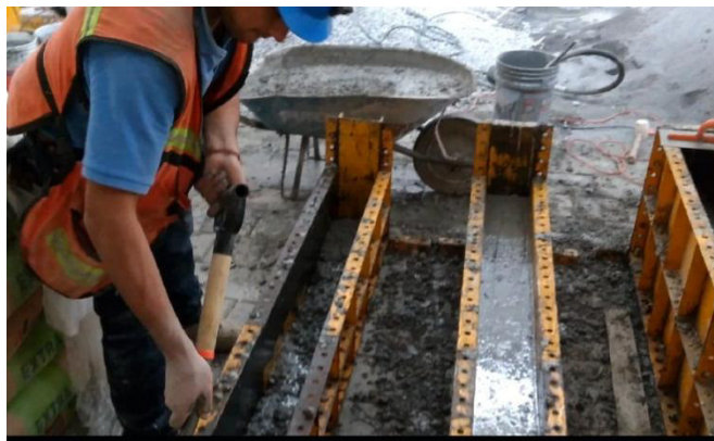
Figura 17. Traslado y colocación de la mezcla de concreto.
