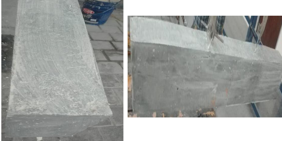
Figura 19. Curado de las vigas con membrana plástica.
