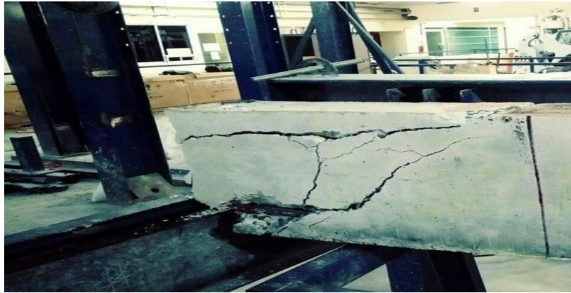
Figura 6. Viga reforzada con refuerzo tradicional en la cual se puede ver una falla frágil debido al cortante.
