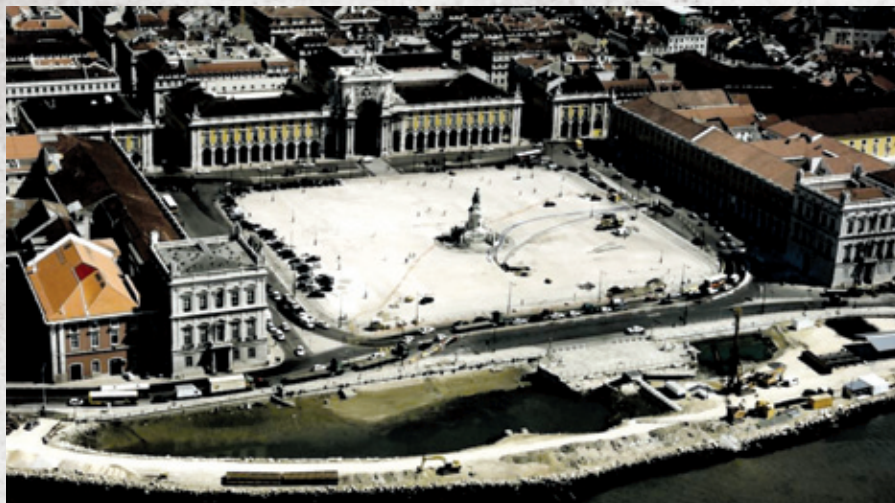
1. Vista aérea da Praça do Comércio com o Cais das Colunas parcialmente desmontado (Junho 2000).
