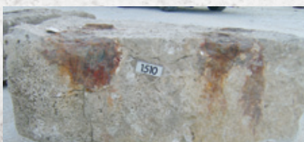
4. Pormenor de içamento de bloco pétreo.
