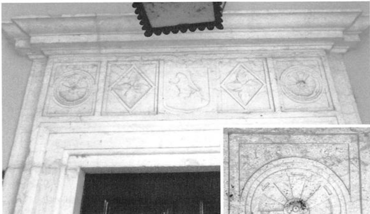
Figura 11 – Pormenor do emoldramento da porta de acesso à capela e pormenor com data. (Foto ACA, Nov. 2013)
