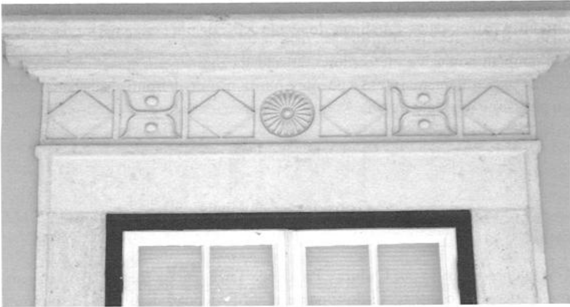
Figura 12 – Pormenor do emoldramento da porta de entrada nobre, na loggia, fachada sul. (Foto ACA, Nov. 2013)
