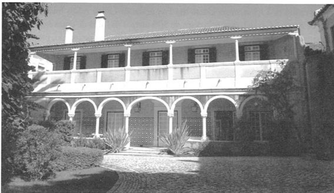
Figura 3 – Palácio da Terrugem, alçado principal/sul. (Foto Carmo Montanha, CMO, Set. 2009)
