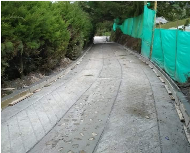
Figura 3: Construcción vial vereda La Esmeralda
