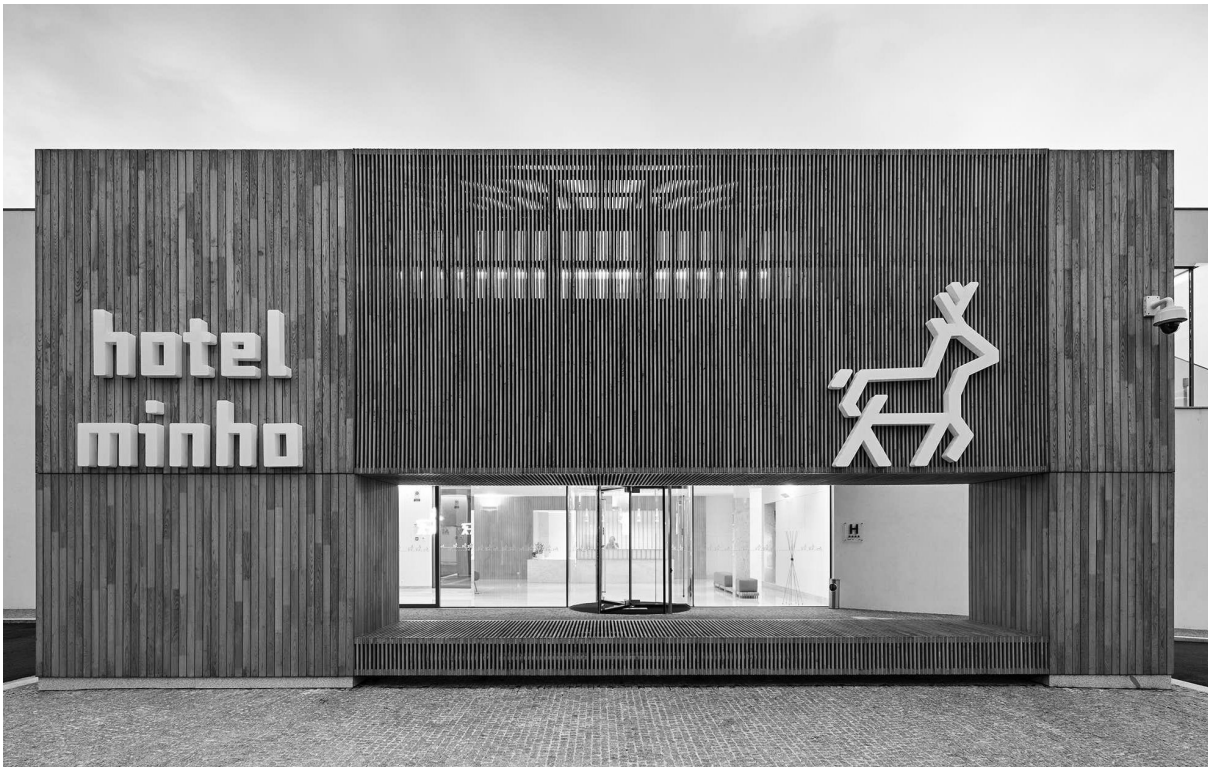
Fig. 12/13 O projeto de rebranding para o Hotel Minho surge da intenção de criar um novo conceito de design que refletisse a contemporaneidade do edifício e o caráter da região.
