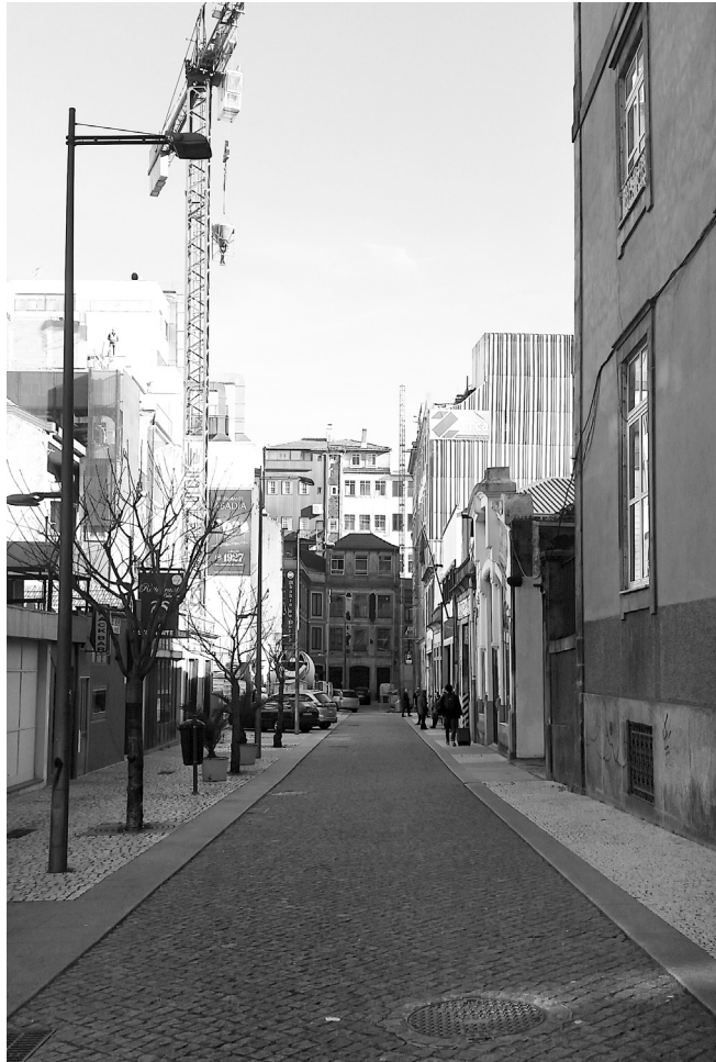
Fig. 10/11 Fotografias do exterior do edifício em reabilitação visto a partir da rua do Ateneu Comercial do Porto.
