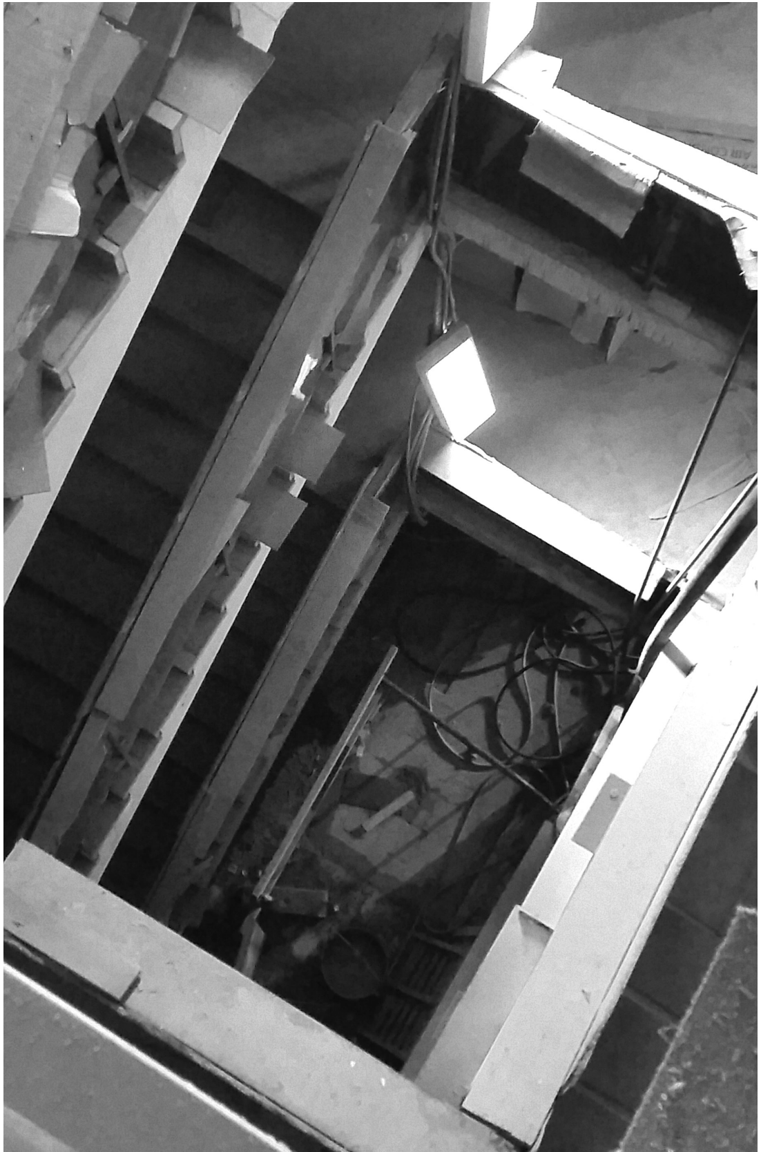
Fig. 33 Vista do vão de escadas do edifício em obras.
