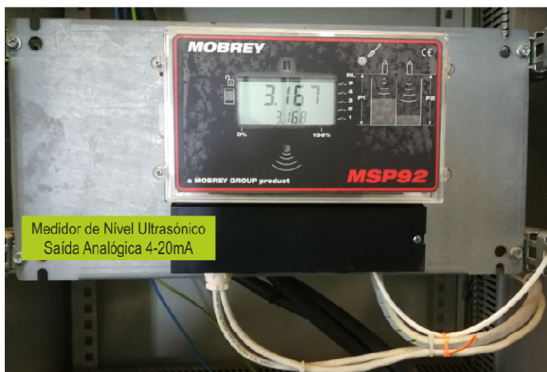
Figura 4-5: Medidor de Nível Ultrassónico, saída 4-20mA
