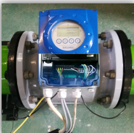
Figura 3-5: Caudalímetro com comunicação ModBus e 4-20mA
