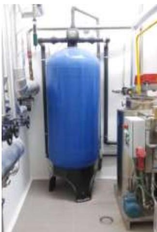
Figura 8 - Filtro de retirar o cloro da água (Santos, C.(2017))
