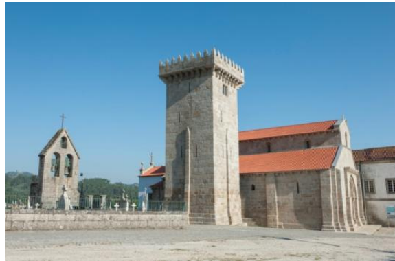
Foto 6 – Igreja do Mosteiro do Salvador de Travanca, depois da intervenção | exterior (2015)
