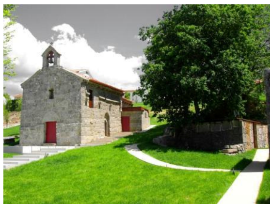
Foto 3 – Igreja de S. Mamede de Vila Verde, depois da intervenção | exterior (2008)
