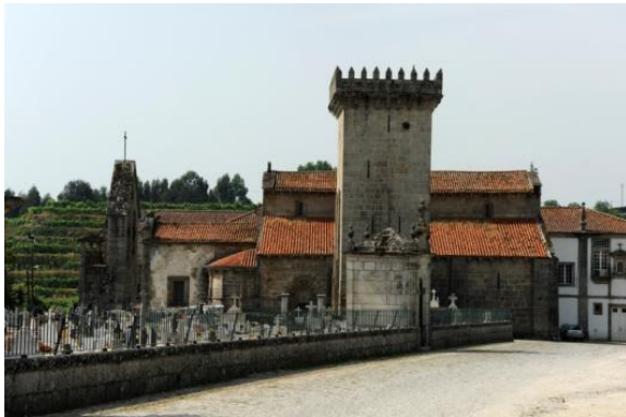
Foto 5 – Igreja do Mosteiro do Salvador de Travanca, antes da intervenção | exterior (2012)
