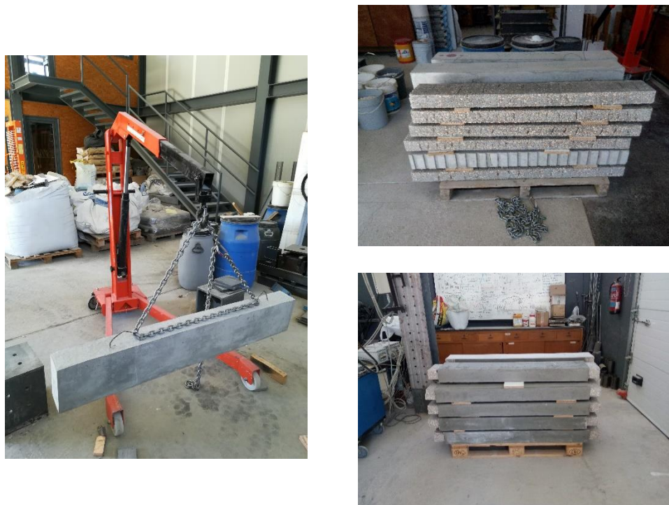
Figura 3.24 – Descofragem e cura prolongada das vigas
