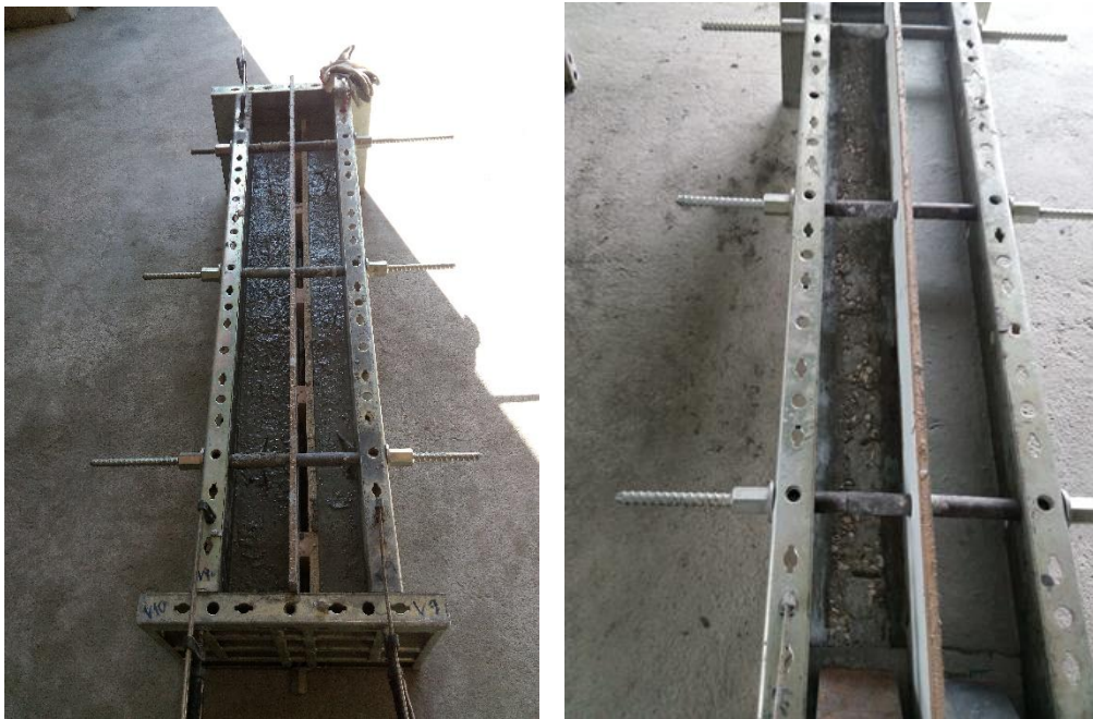
Figura 3.23 – Betonagem e cura das vigas
