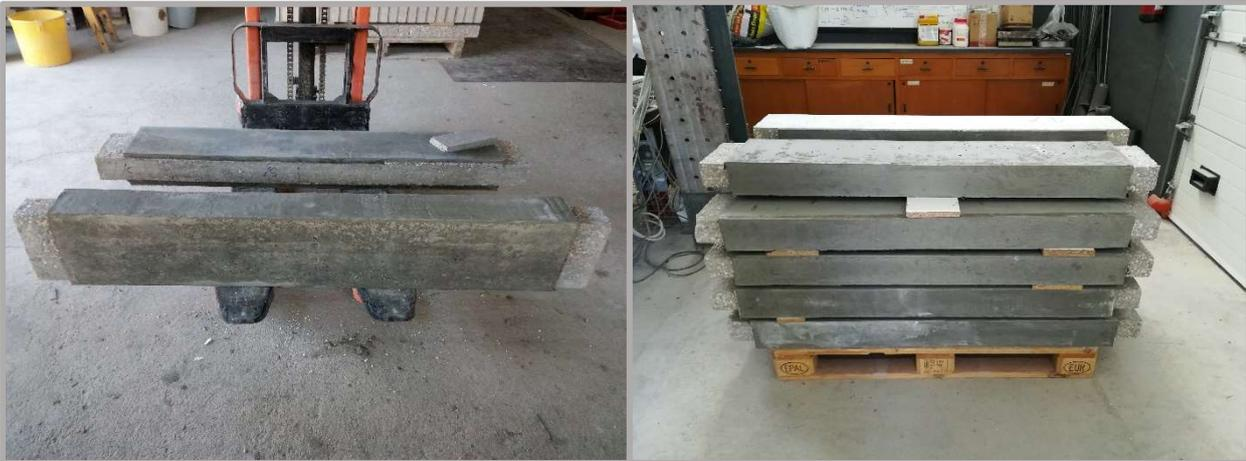
Figura 3.35: Descobragem e armazenamento das vigas
