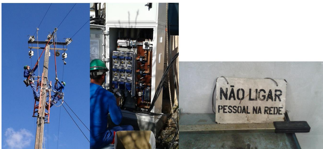
Figura 4.20 – Cortes visíveis na rede.
