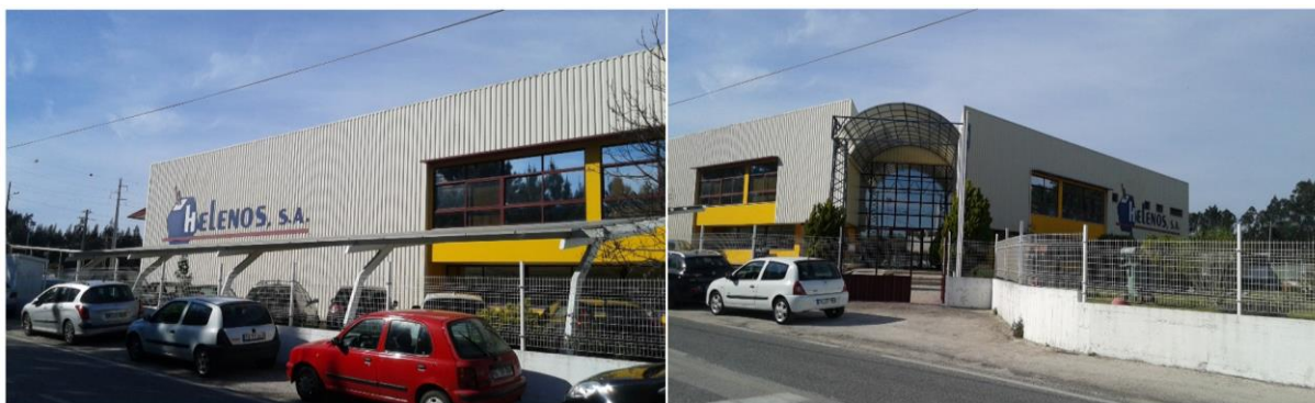
Figura 2.3 – Fachada principal e entrada do edifício da Helenos, S.A.
