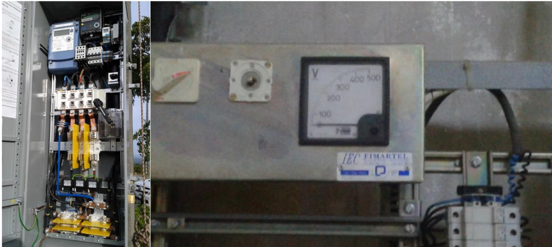
Figura 4.22 – Verificação de ausência de tensão.
