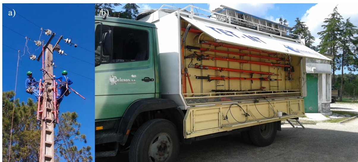
Figura 4.18 – a) Execução de TET, b) colocação de material na viatura de TET.
