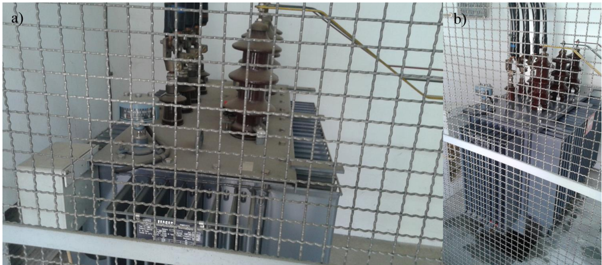
Figura 6.9 – a) Transformador de potência antes da limpeza, b) transformador de potência depois da limpeza.
