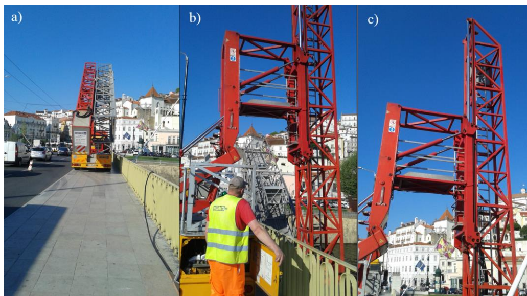
Figura 6.25 – a) Grua under bridge a avançar na ponte, b) grua under bridge a baixar a sua plataforma hidráulica, c) acessos da grua under bridge .
