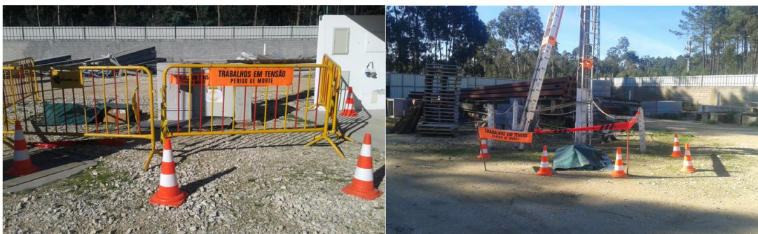
Figura 4.24 – Delimitação da zona de trabalhos.
