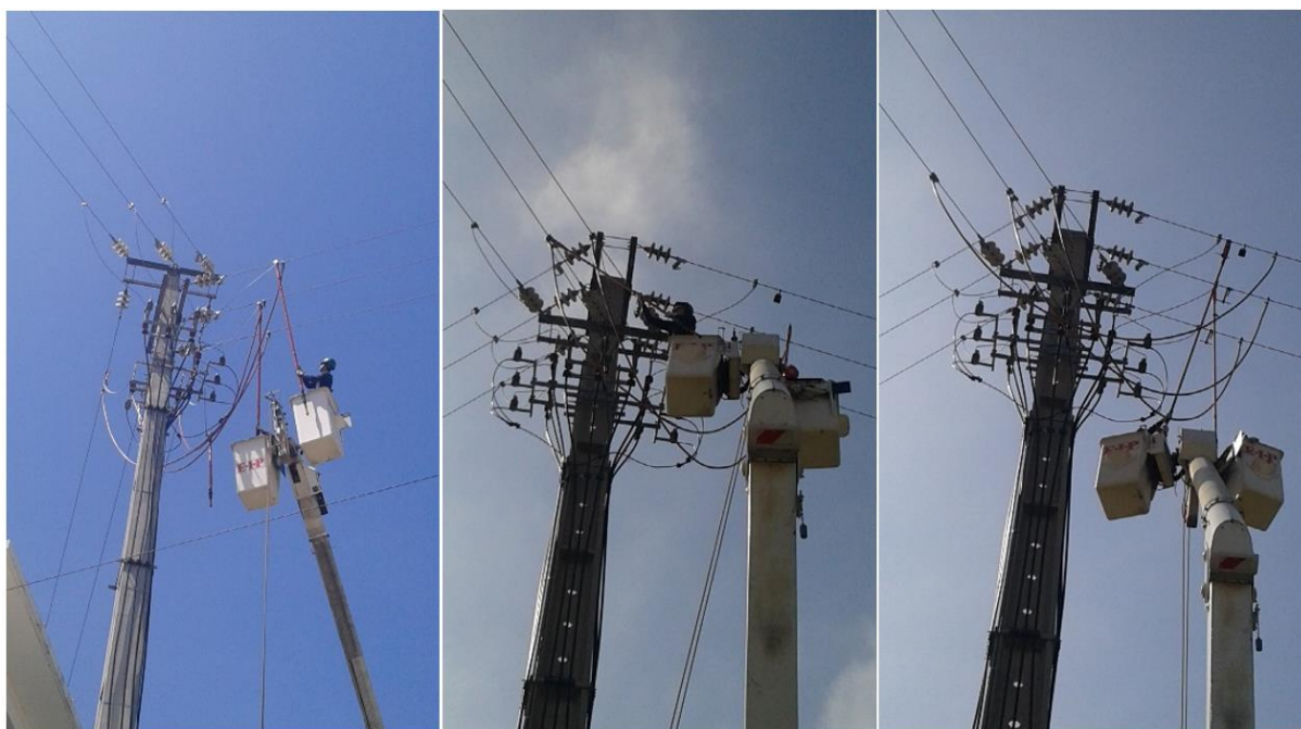
Figura 4.8 – Execução de Trabalhos em Tensão.
