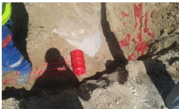
Figura 3.6 – Colocação de fita de sinalização vermelha e de rede de sinalização vermelha.
