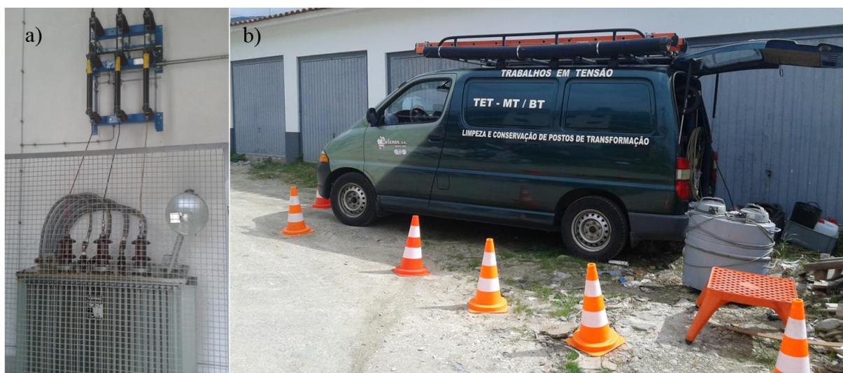
Figura 6.8 – a) Transformador de potência após a limpeza, b) viatura de transporte de material para TET.
