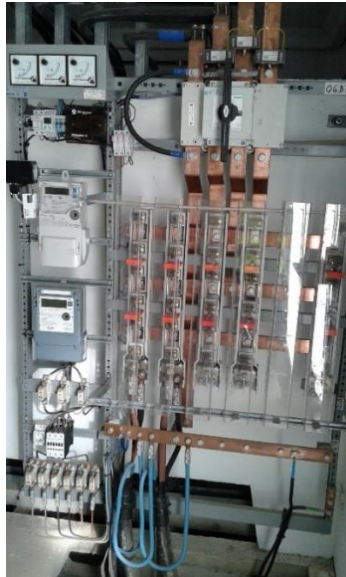
Figura 5.5 – Visualização de um QGBT de quadro aberto CA2 de um PTD de Cabine Baixa.
