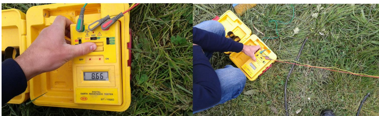
Figura 5.12 – Medição da resistência de contacto do eléctrodo de terra.
