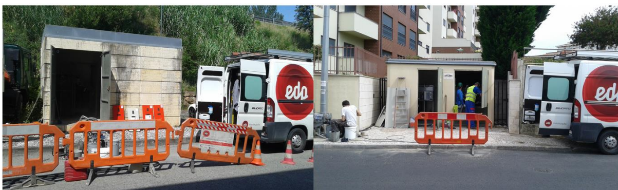
Figura 4.9 – Trabalhos de manutenção em PT's.
