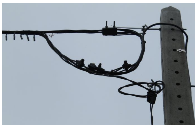
Figura 3.2 – Rede aérea de BT em cabo torçada.
