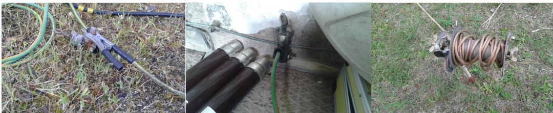
Figura 4.23 – Ligações à terra e em curto-circuito.
