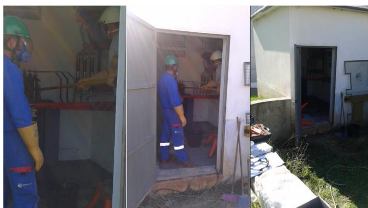
Figura 4.11 – Trabalhos de limpeza e conservação de um PT.
