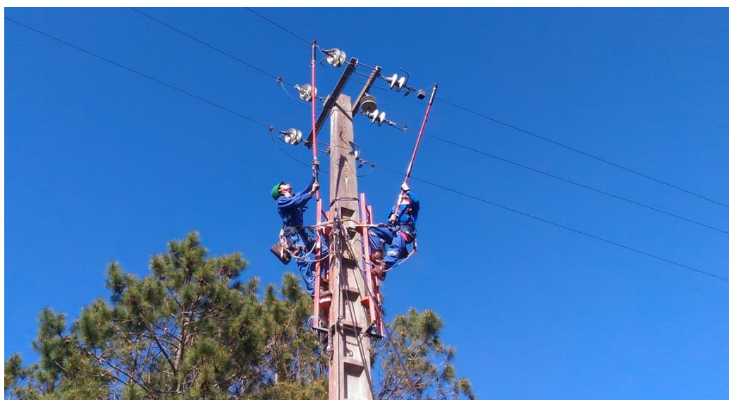
Figura 4.5 – Trabalhos em Tensão.
