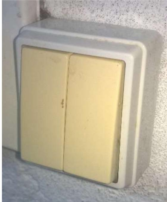
*Figura 29 - Exemplo de oxidação em plásticos*
