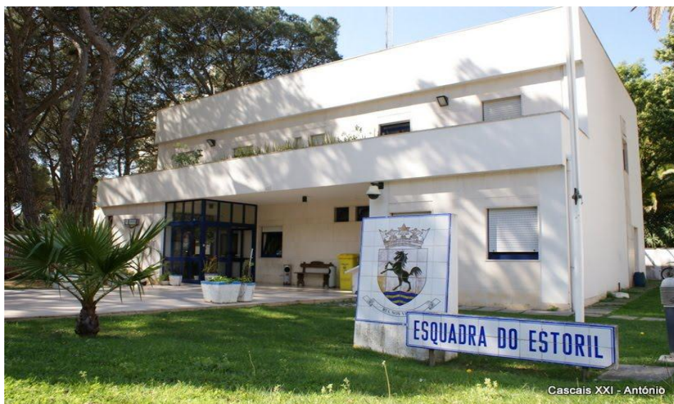
Imagem 13 - Edifício da 51ª Esquadra – Estoril
