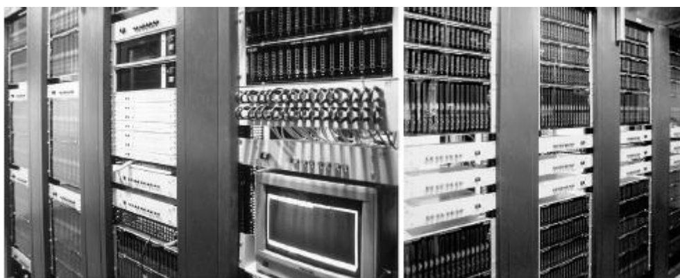
Figura 9 - Exemplar de um Video Matrix Switcher, instalado no casino Star City em Sidney – Austrália (contém mais de mil câmaras e oitocentos gravadores de vídeo)
