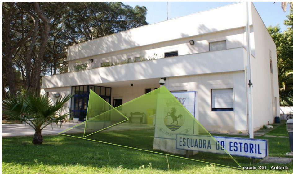
Imagem 14 - Duas câmaras de videovigilância cobrem a área frontal do edifício.
