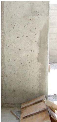
Figura 1. Excesso de vazios visíveis na superfície de um pilar.
