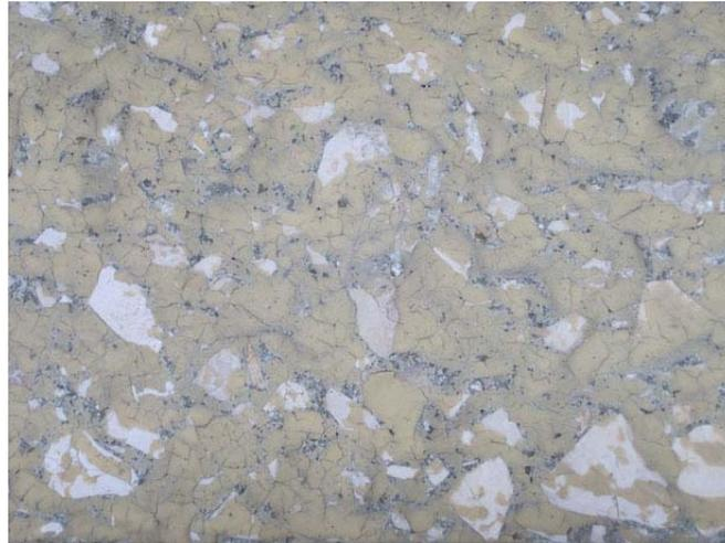
Figura 5. Pormenor da degradação da tinta.
