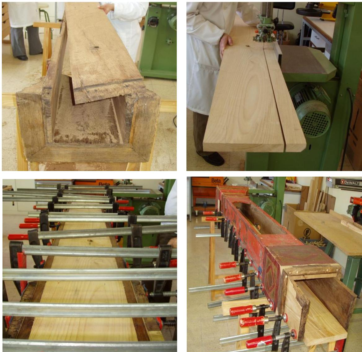
Figura 31. Substituição da tábua do verso da caixa de relógio. Imagens do acerto da nova tábua e dos apertos, com grampos, após colocação de cavilhas e adesivo<sup>136</sup>.
