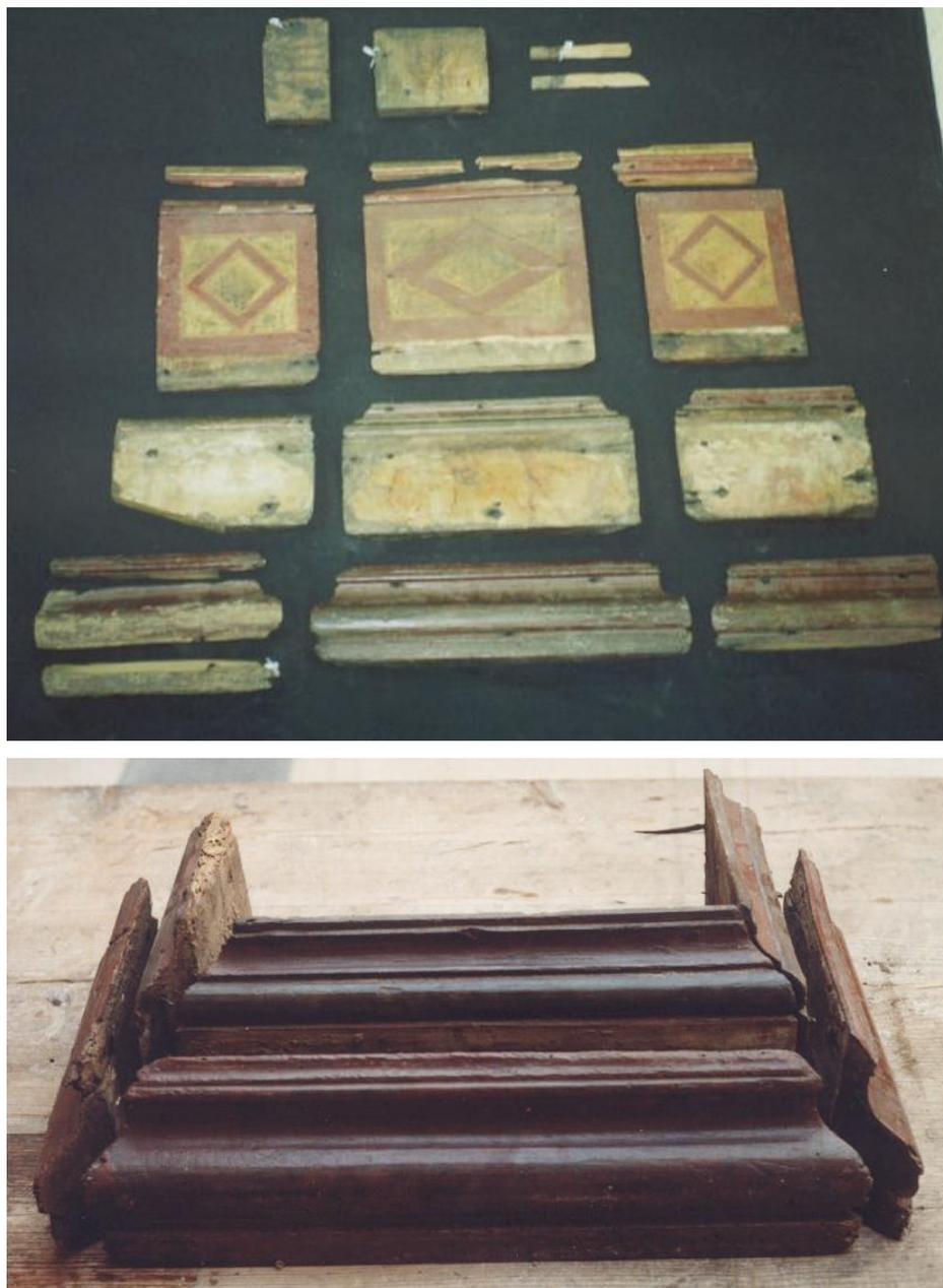
Figura 7. Em cima, esquema da construção da base e dos frisos do corpo inferior da caixa de relógio, após desmontagem dos elementos. Podem-se observar as marcas dos elementos metálicos utilizados na assemblagem dos vários elementos<sup>74</sup>.
