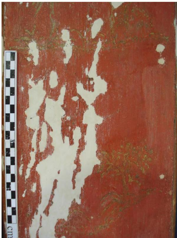
Figura 37. Pormenor da porta frontal da caixa de coluna, cujas áreas de lacuna foram preenchidas com camadas de preparação tradicional branca<sup>142</sup>.
