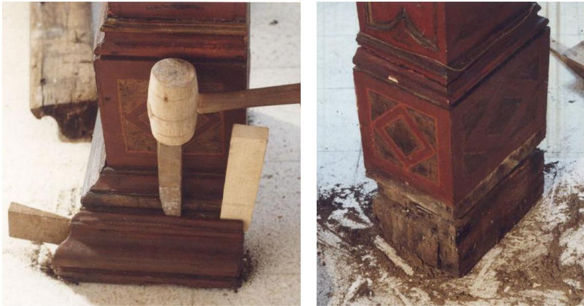
Figura 29. Fase inicial da desmontagem dos frisos (à esquerda) e frisos já desmontados (à direita). Na imagem da direita é visível o mau estado de conservação da base e as alterações consequentes dos factores ambientais e biológicos sobretudo<sup>134</sup>.
