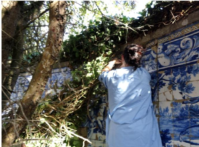
Fig. 62 – Remoção da vegetação.
