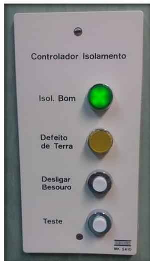
Figura 37 - Controlador Isolamento.
