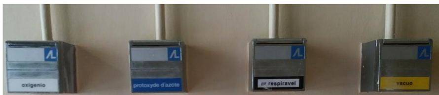
Figura 30 - Sistemas de fornecimento de gases.
