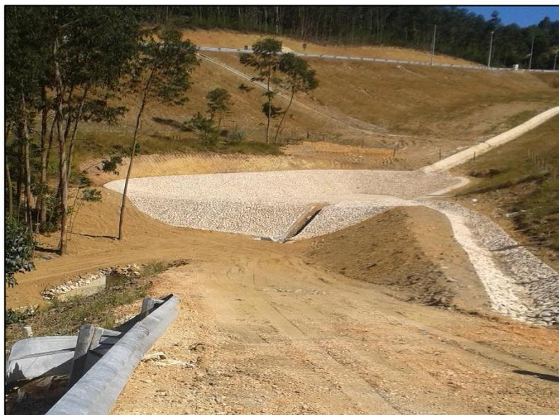
Figura 25 – Bacia de retenção (Fotografia cedida pela Águas de Coimbra, 2017).
