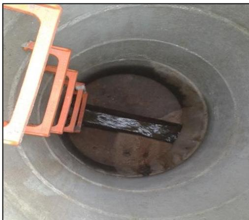
Figura 15 – Interior de câmara de visita (Fotografia cedida pela Águas de Coimbra, 2014).
