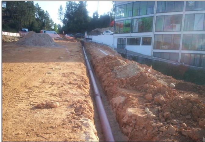
Figura 11 - Execução de um emissário (Fotografia cedida pela Águas de Coimbra, 2009).
