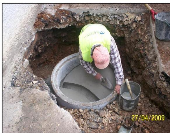
Figura 14 – Execução de uma câmara de visita (Fotografia cedida pela Águas de Coimbra, 2009).
