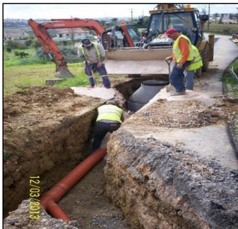
Figura 10 - Execução de um coletor em Polipropileno Corrugado (Fotografia cedida pela Águas de Coimbra, 2013).
