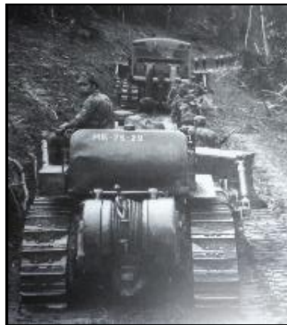
Figura nº 23 – Construção de uma estrada
