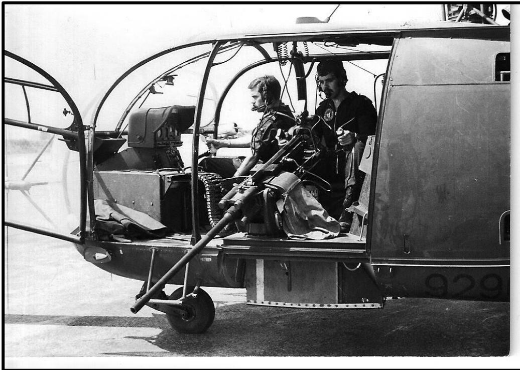
Figura 18 – Alouette III em configuração helicanhão
