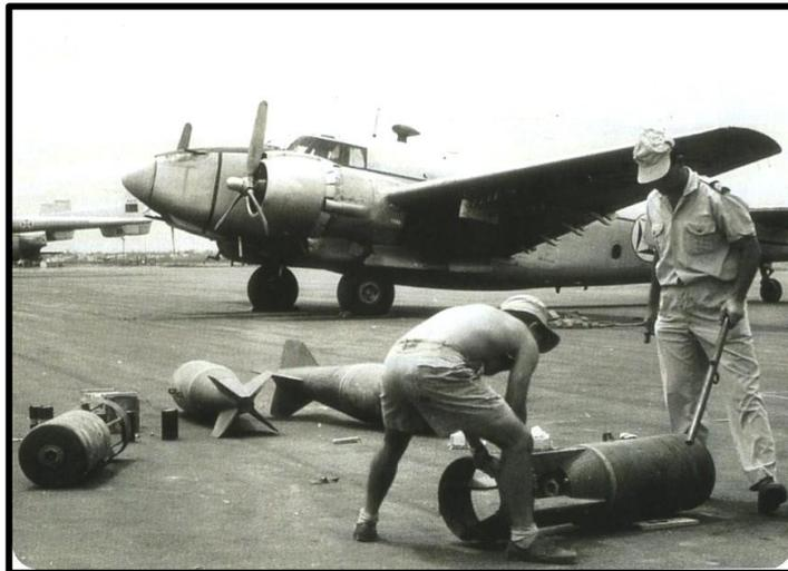
Figura 17 – PV2 a ser carregado com bombas
