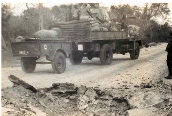
Figura 11 – Viatura rebenta minas com atrelado 1ton para aumentar largura dos trilhos (Coimbra, s.d.).
