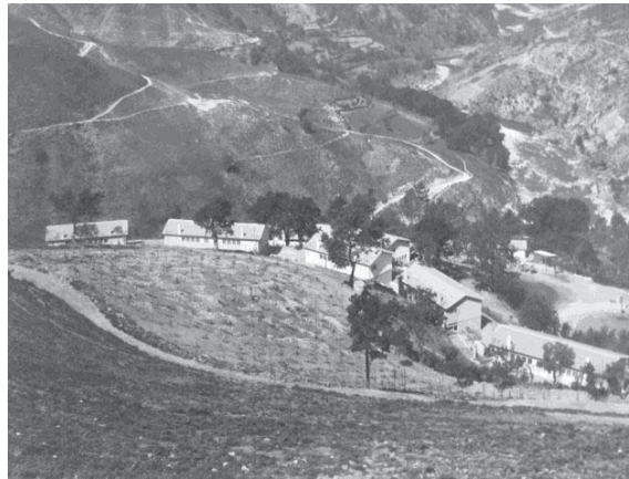
Figura 6. 1º fase construída do bairro de Vila Nova, 1950 – Fotografia Alvão, Arquivo Fotográfico da EDP, Porto.
