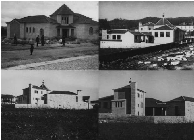
Escola Primária e Cantina de Alijó. Fotos durante a construção. DGEMN, DSID. IPA nº PT011701010022, Fotos 551915, 551914, 551913 e 551916.
